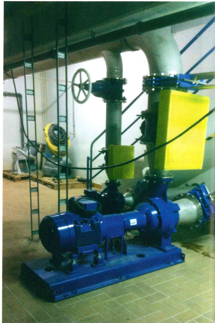
Bild 7 Zulaufpumpwerk
