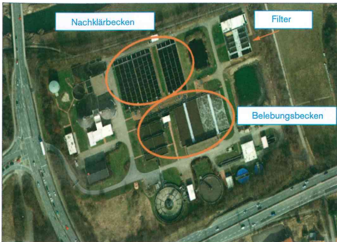
Bild 4 Luftbild der Kläranlage in Bad Oeynhausen
