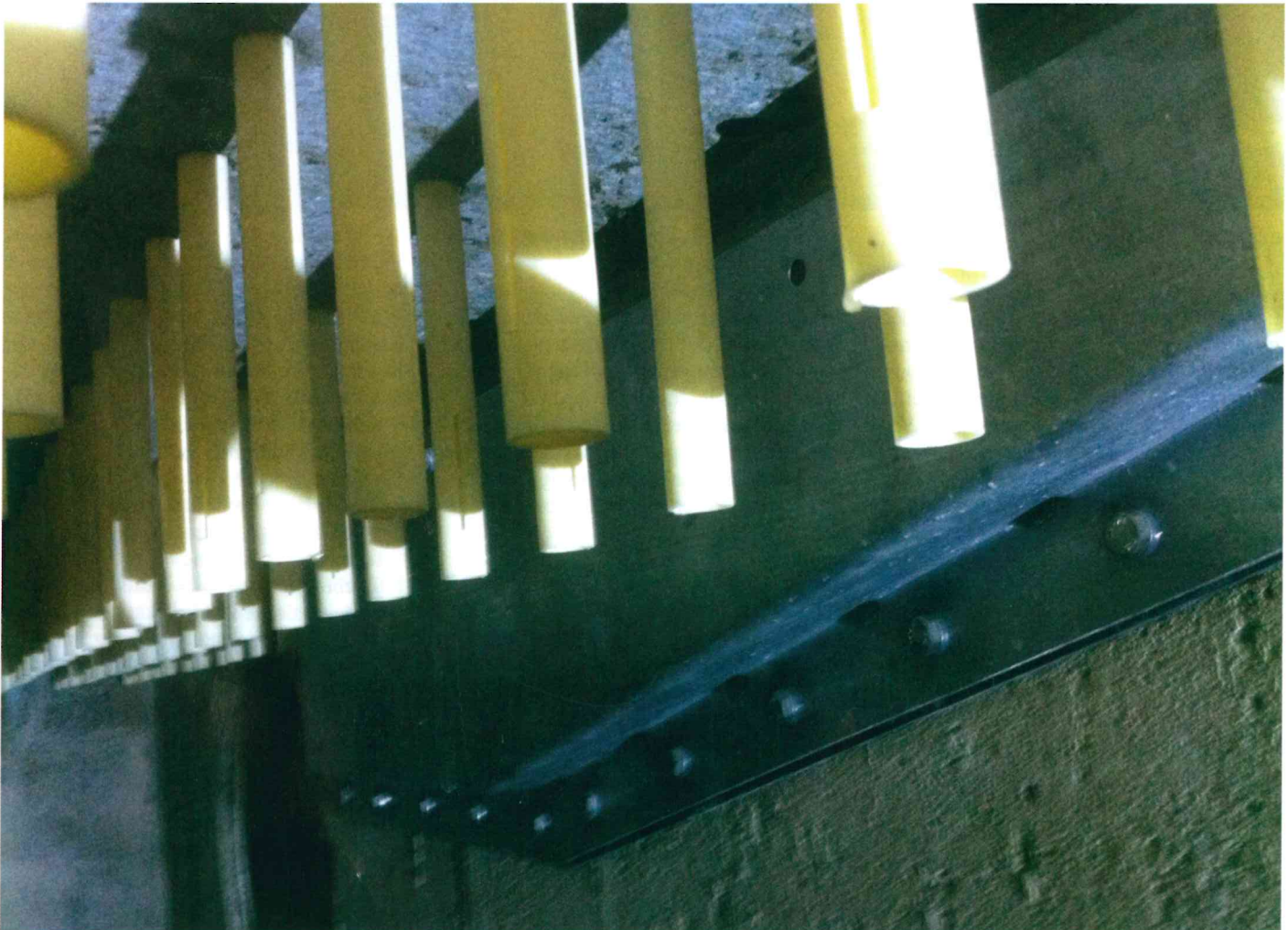
Bild 5 Untersicht Filterdüsenboden mit Lufteintragskasten
