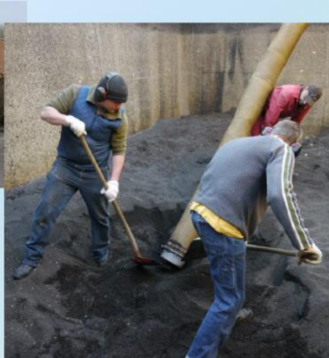
Befüll- und wanddurchgeführte Entleerungsleitung (Storz-A)
