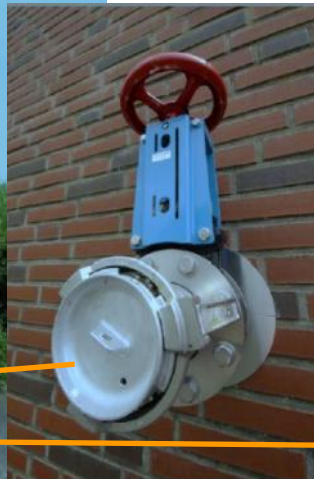
Befüll- und wanddurchgeführte Entleerungsleitung (Storz-A)
