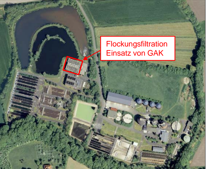
Luftbild des Klärwerks „Obere Lutter“
